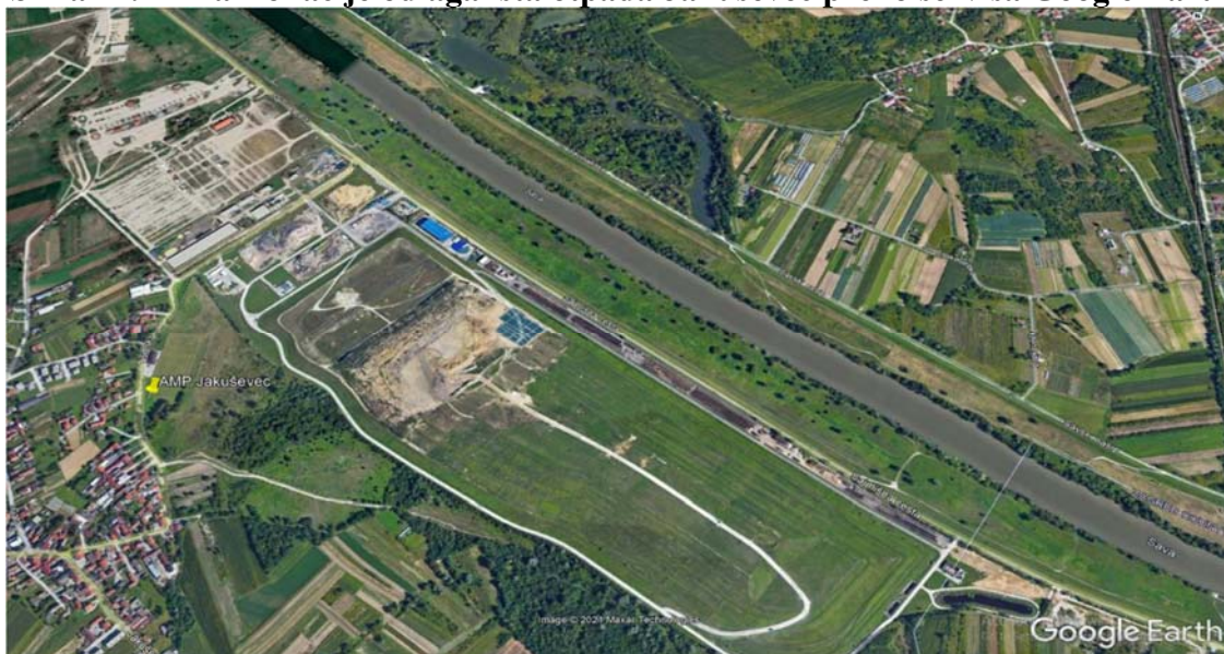
Slika 27. Prikaz lokacije odlagališta otpada Jakuševac preko servisa Google Earth
