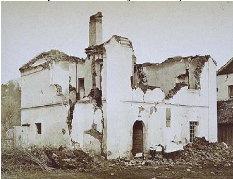
Slika 9. Župna crkva u Kustošiji oštećena u potresu 1880.
