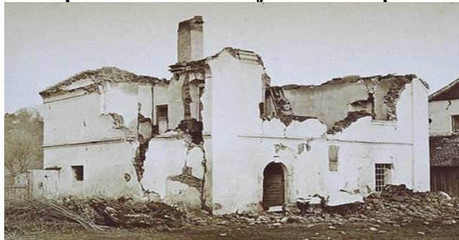
Slika 9. Župna crkva u Kustošiji oštećena u potresu 1880.
