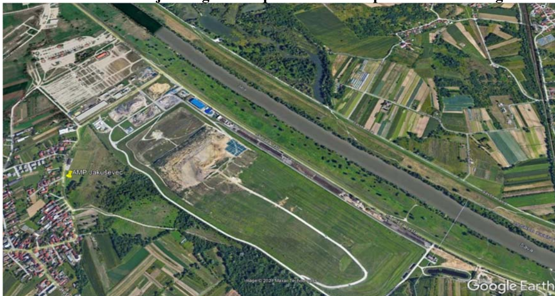
Slika 31. Prikaz lokacije odlagališta otpada Jakuševac preko servisa Google Earth
